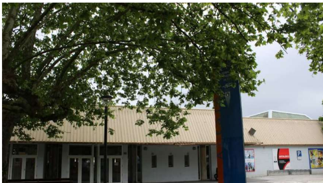
El polideportivo Artaleku cierra hoy y mañana por una incidencia en el suministro de agua
